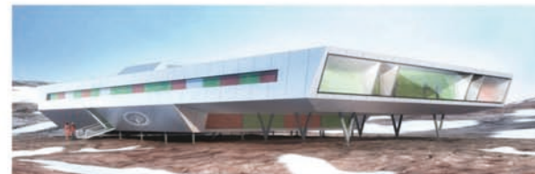
■ In alto il viadotto di Padova est, qui sopra la stazione antartica indiana
